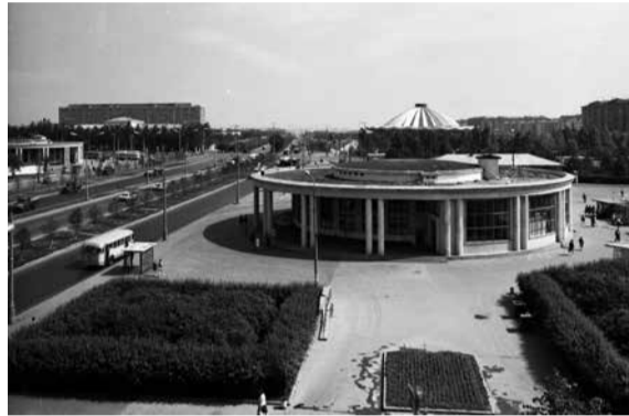
Южный наземный вестибюль станции «Университет», июнь 1972 года
