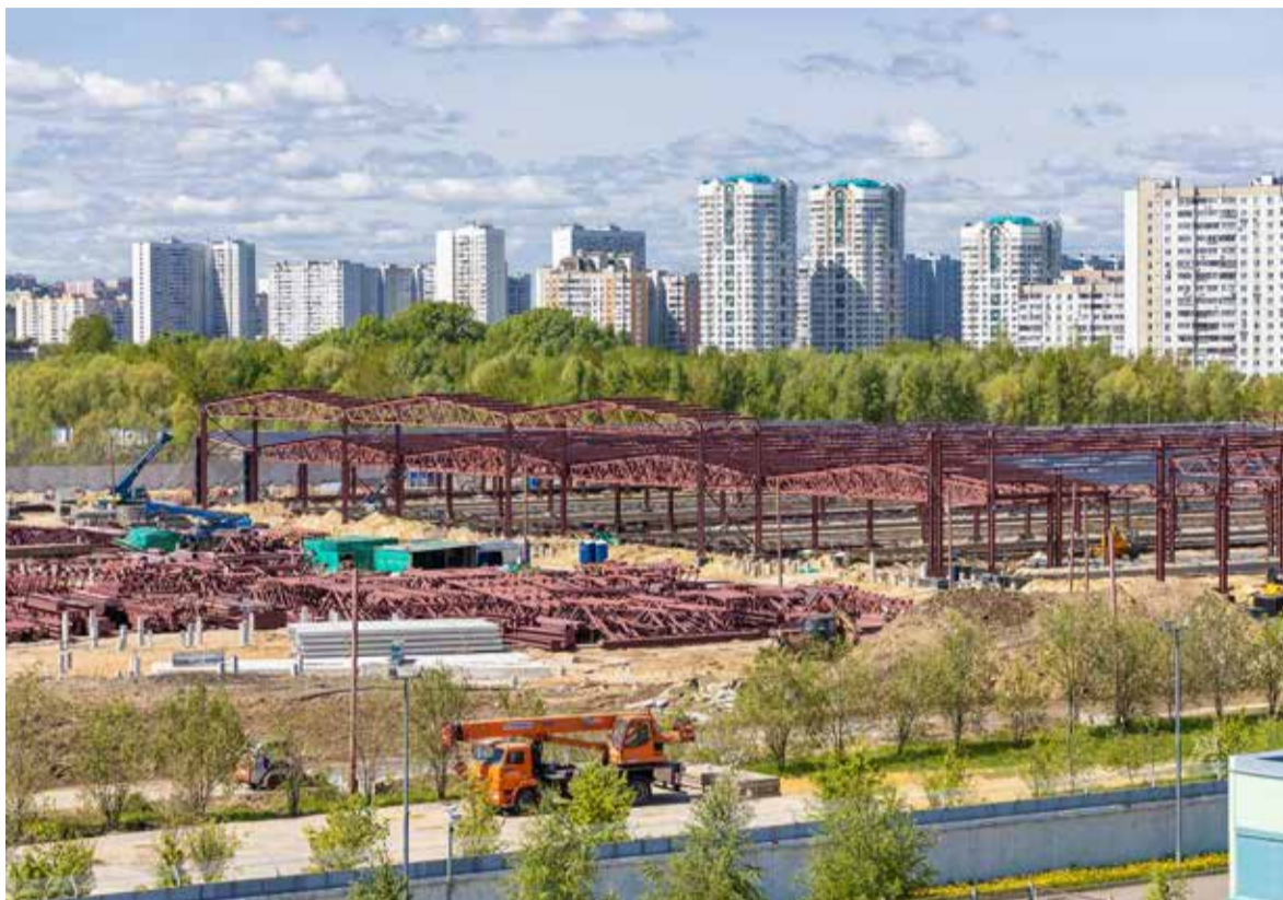
Строительство электродепо «Южное»
