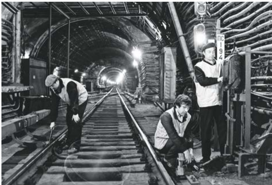
Работники Службы СЦБ и связи в тоннеле во время «ночного окна»
