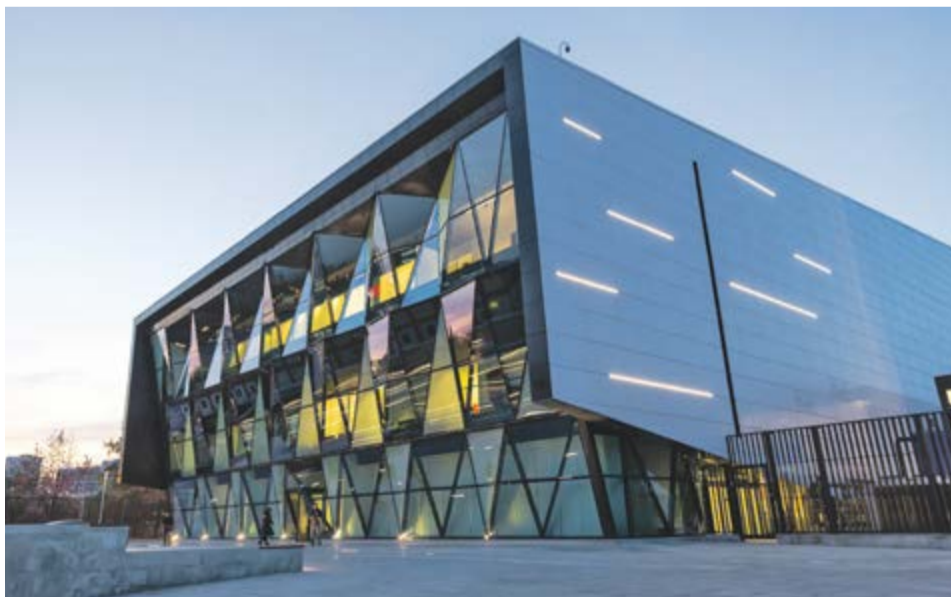
ЕДЦ разместился в здании бывшего кинотеатра «Ереван» на Дмитровском шоссе, 82. Здесь также находится Центр управления обеспечением транспортной безопасности метрополитена
