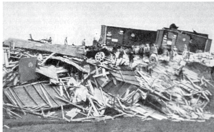
Последствия крушения поезда № 110 на перегоне Изола – Невель. 22 октября 1924 года
