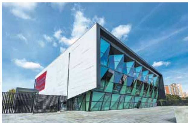
Единый диспетчерский центр метрополитена
