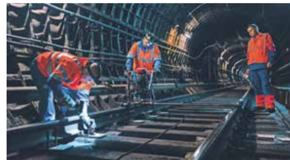
«Ночное окно» в метро. Работы по ремонту пути
