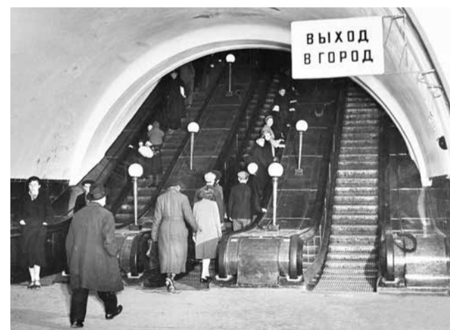
Эскалаторы на станции «Дзержинская» («Лубянка»)
