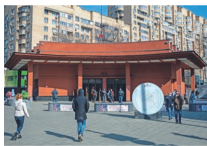
Так выглядит вход на станцию «Красносельская» сегодня
