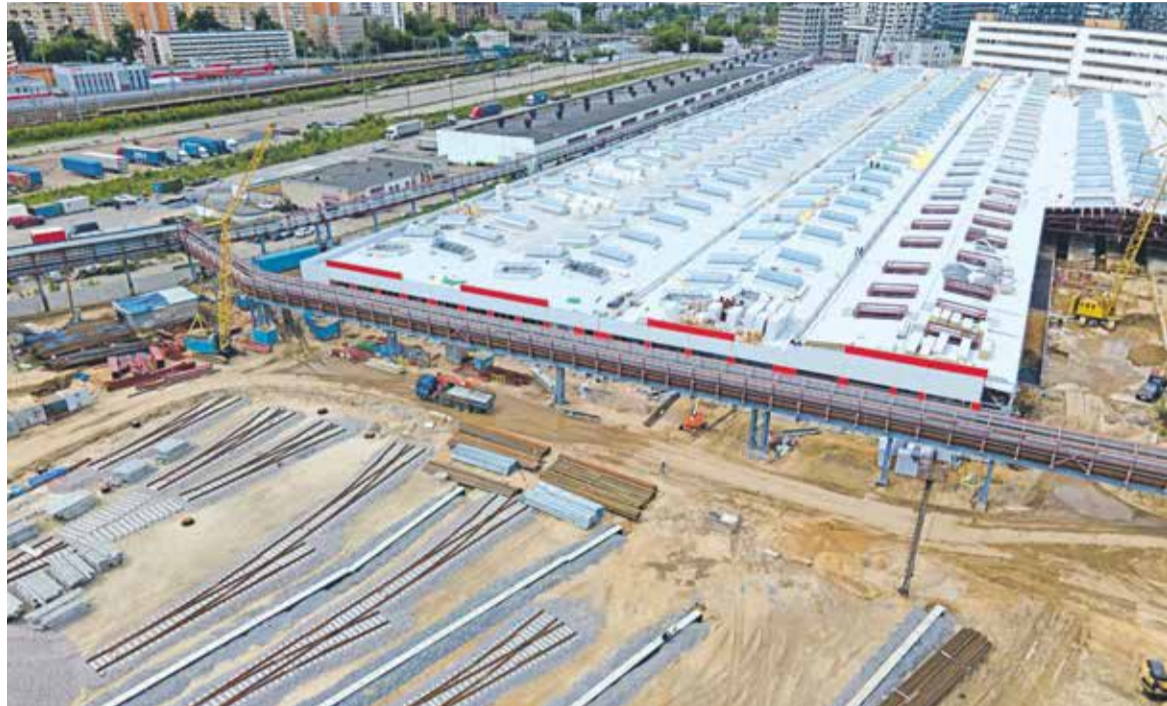
Строительная площадка электродепо «Нижегородское»
