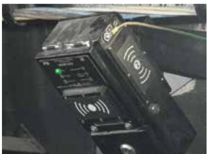
Датчики с зелёными огоньками установлены по всей длине тоннеля – это надёжная модернизированная защита от несанкционированного проникновения на пути
