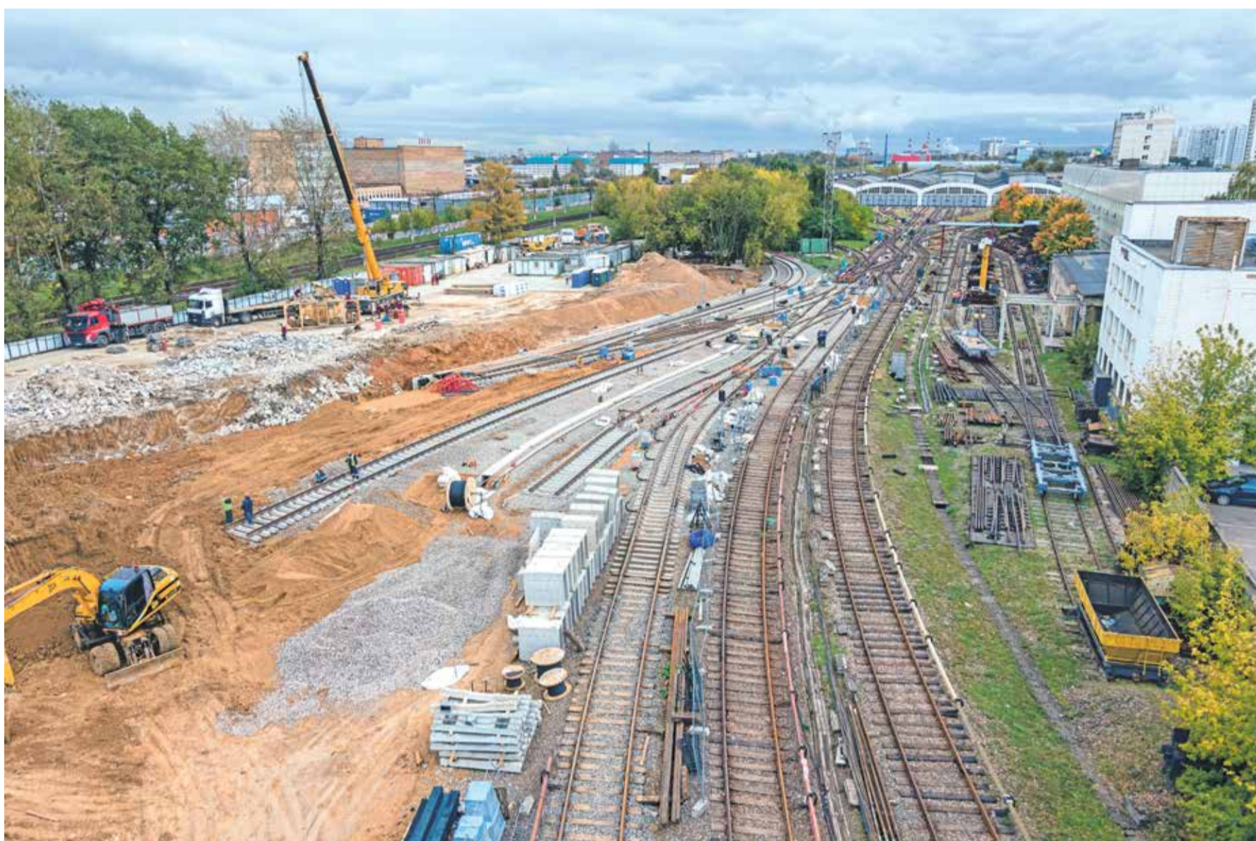
Электродепо «Замоскворецкое». Реконструкция парковых путей
