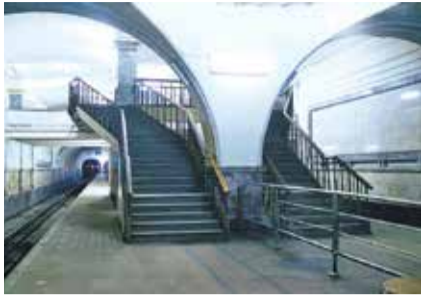
Дополнительные лестницы на станции «Сокол» (не сохранились)
