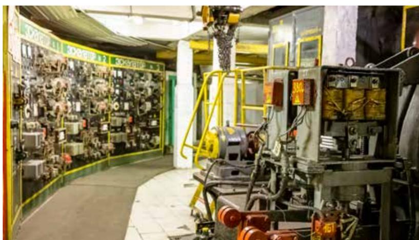
Машинные залы разных поколений. Эскалаторы различаются электроприводом, основными узлами и системой управления
