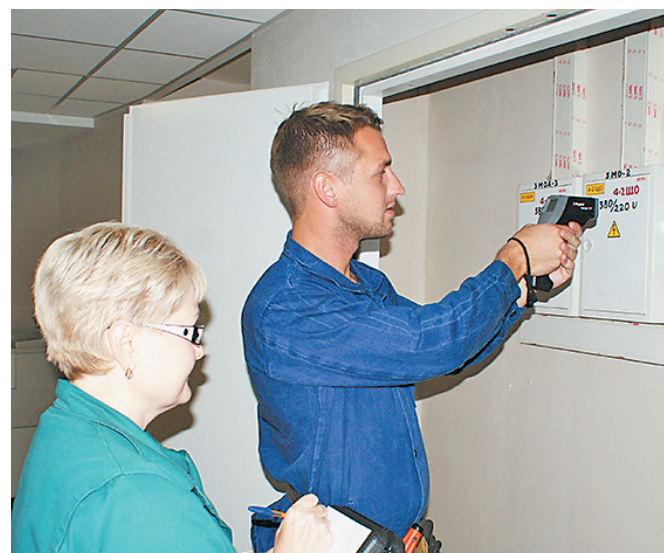
Сергей Ляхович и Лидия Балашова проверяют работу клемм в щитовой
