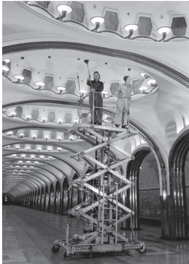
Работники Службы тоннельных сооружений на станции «Маяковская», 1949 год
