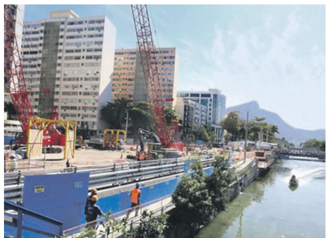
Строительство станции Jardim de Alah
