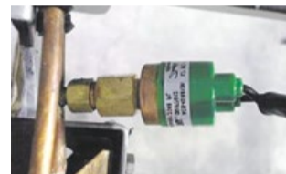
Рис. 8. Реле высокого и низкого давления
