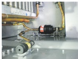
Рис. 4. Фильтр-осушитель
