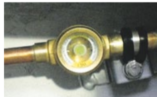
Рис. 6. Визир жидкости
