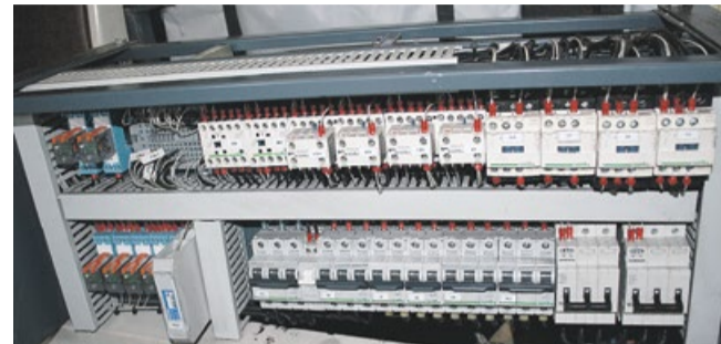
Рис. 9. Панель управления климатической установкой
