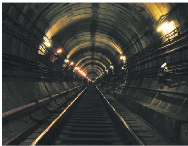
Тоннель до монтажа новых светильников...
