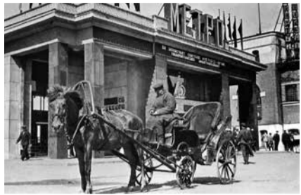
Северный наземный вестибюль станции «Комсомольская» (фото 1935 года). В конце 1940-х годов его разобрали, чтобы построить новый совмещённый вестибюль для двух станций
