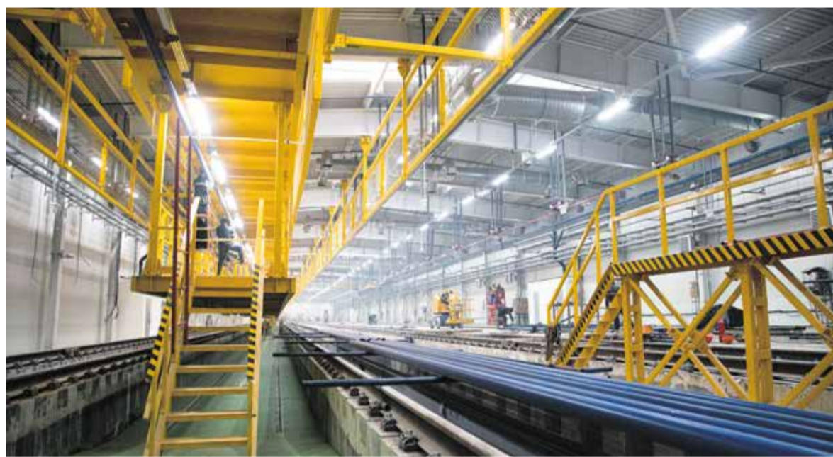
Монтаж оборудования в новом пролёте отстойно-ремонтного корпуса электродепо
