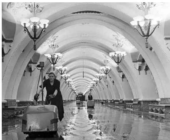
Бригада уборщиц с поломочными машинами на станции «Арбатская» (1969)
