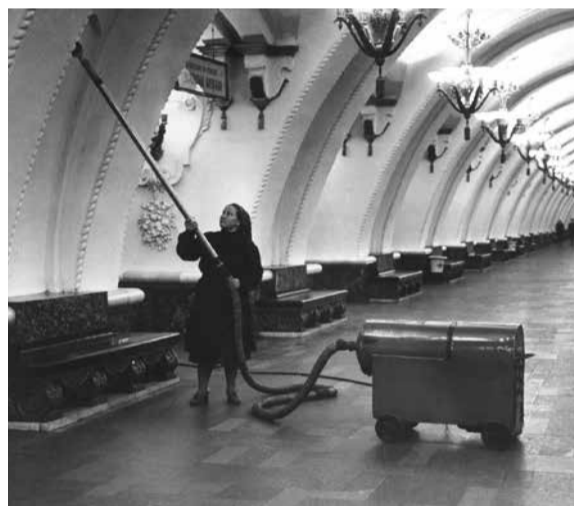
Уборка станции «Арбатская» с использованием пылесоса (1955)
