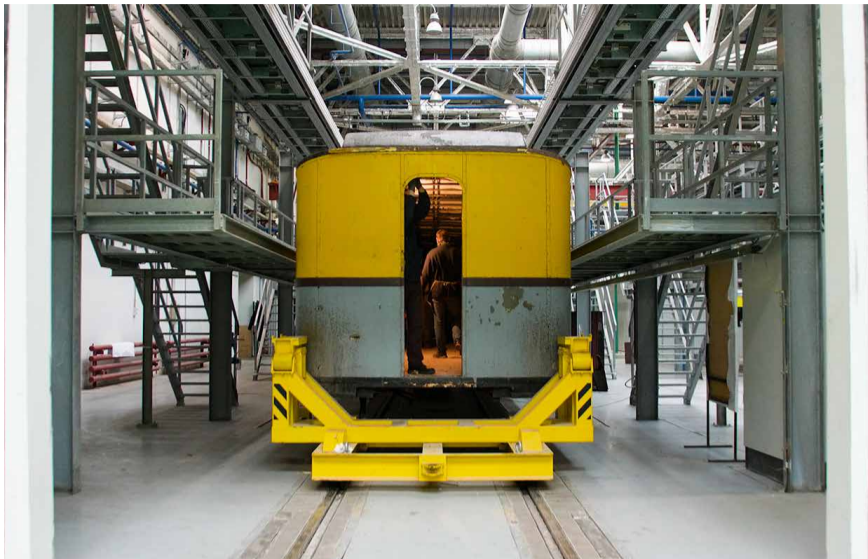
Работы по реконструкции вагона «В» идут в Вагоноремонтном комплексе метро
