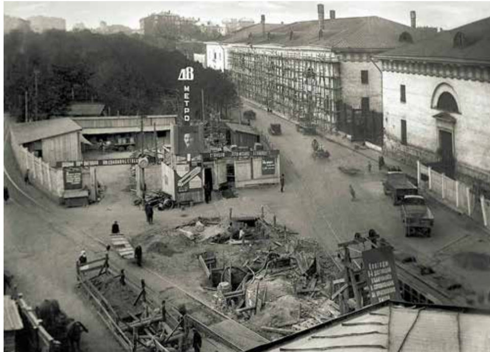
Сооружение южного наземного вестибюля станции «Крымская площадь» (1933)
