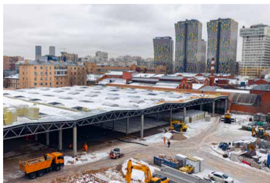
Реконструкция производственного корпуса трамвайного депо им. Апакова. 2 марта 2023 года
