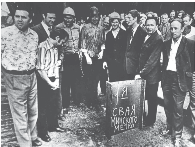
1. Первая свая минского метро 2. Выход проходческого щита из правого перегонного тоннеля на станции «Площадь Ленина» 3. Первый поезд Минского метрополитена
