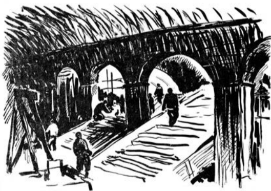
Сооружается станция «Пушкинская» (рисунки художника В. Чапкина из журнала «Метрострой», № 8, 1975)
