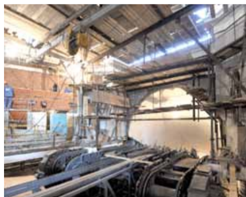
Заканчивается монтаж, такелаж эскалаторов в переходе, начинается третий, последний этап: отделочные работы
